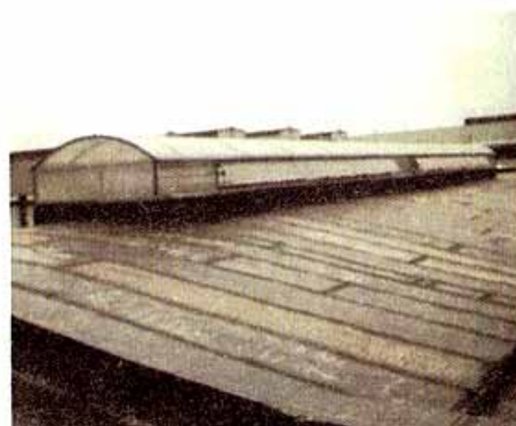
排架结构屋脊电动采光排烟天窗
